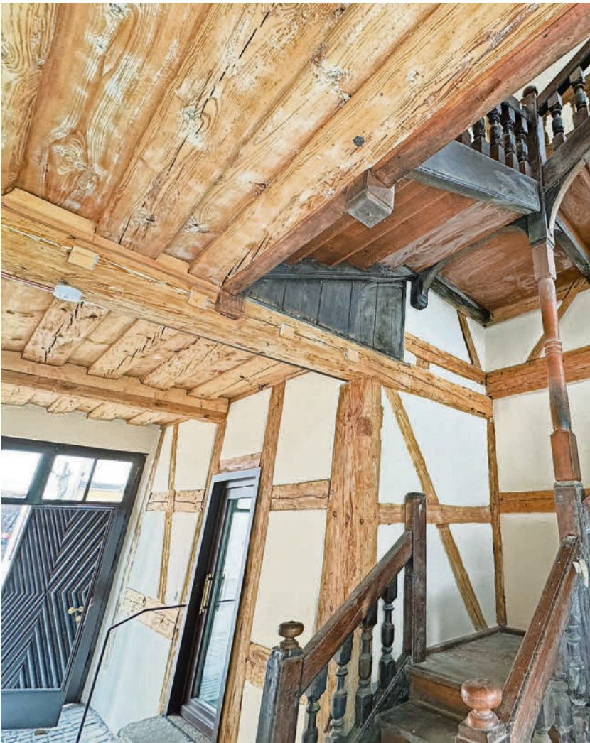
Im historischen Teil des alten Landratsamts Erlangen werden noch Restarbeiten abgewickelt.
