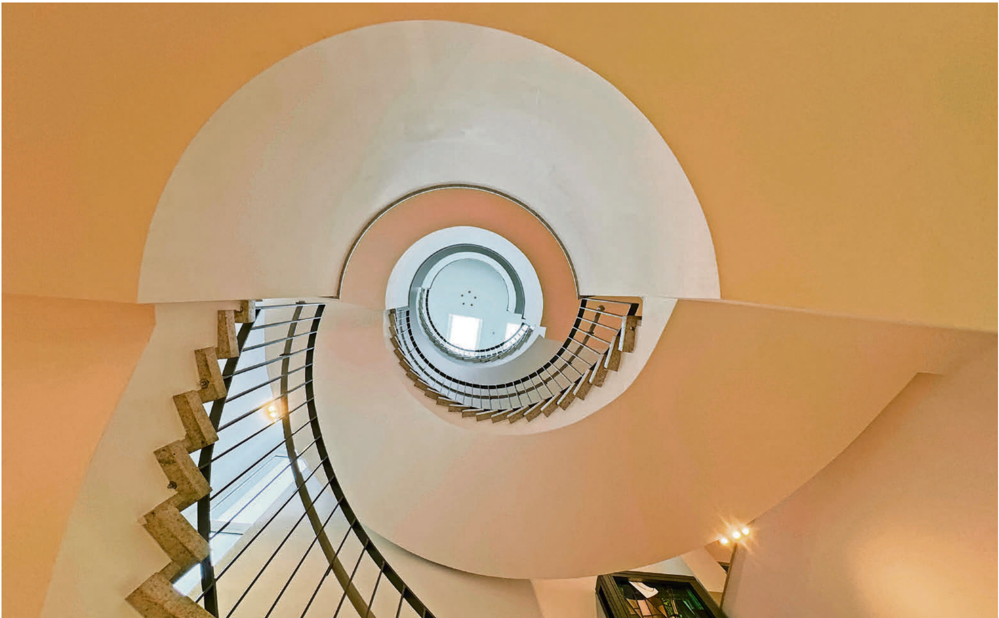
Atemberaubend: das restaurierte und erweiterte Treppenhaus im ehemaligen Verwaltungstrakt des Landratsamtes am Marktplatz.
